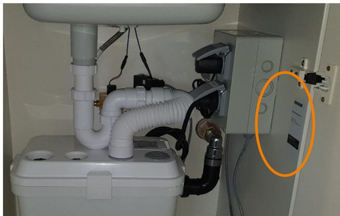
Abb. 2: Beispiel Typenschild Aquamobil und Platzierung
