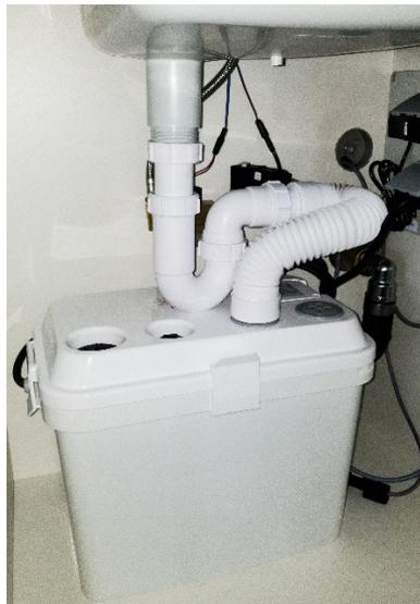
Abb. 5: Abwasserhebeanlage
