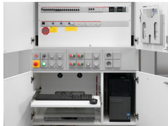
Oben: Elektro-Unterverteilung, Mitte: Integriertes Multimediafach
